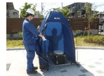
④マンホールトイレ
