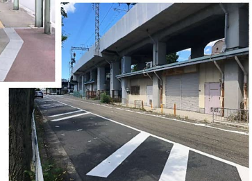
公園北側道路（現況）
