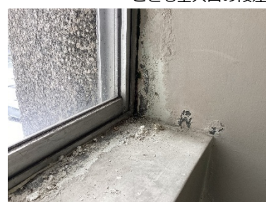
雨漏りによる劣化
