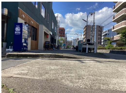
図表 36 武庫之荘南部区画第98号線の 1 の車道と暗渠部分の段差
