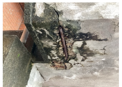
露出した鉄筋
