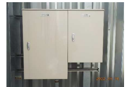
左：イベント盤 (主幹75A) 右：コンセント盤 (6回路分)
