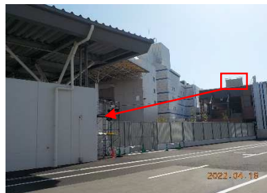
上記予備電灯をステージで使用の場合 架空で配線の必要あり。
