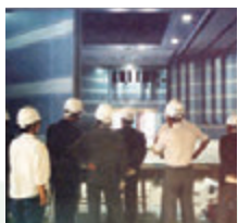
オクトホール建築現場
