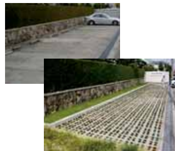
制度を活用した駐車場緑化（武庫之荘）
