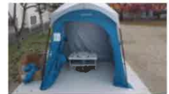
マンホールトイレの設置例
