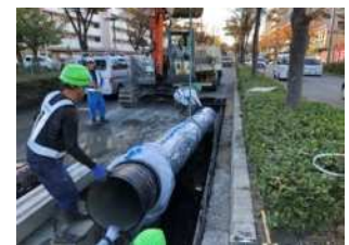
配水管更新工事
