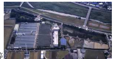
園田配水場 供用開始：昭和 42 年
