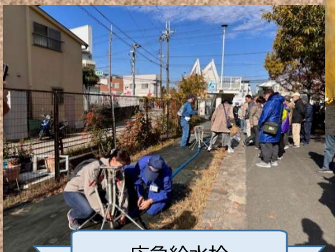
応急給水栓 設置訓練
