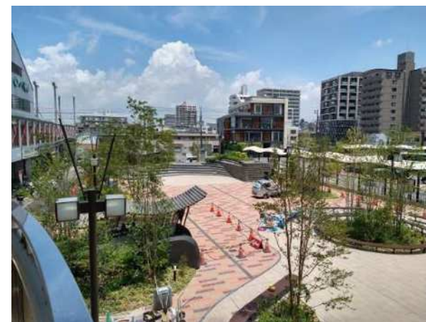
阪神出屋敷駅北側の改修
