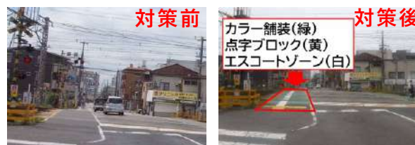
図 4.25 踏切の安全対策
