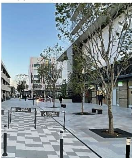
図 - 修景整備された道路空間
