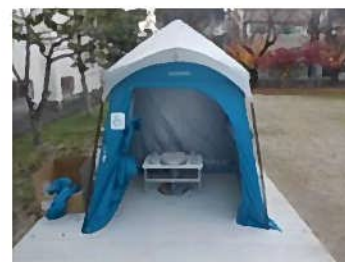
マンホールトイレの設置例
