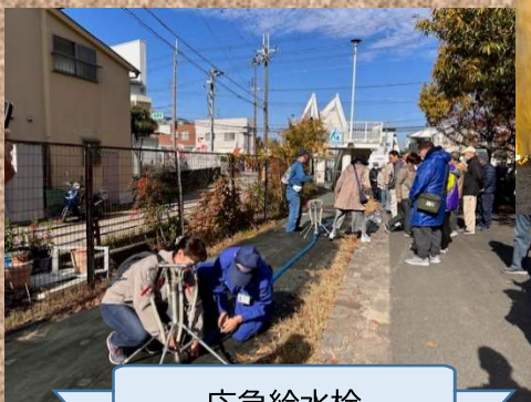
応急給水栓 設置訓練
