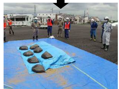
改良積土のう工法
