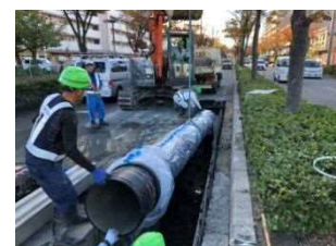
配水管更新工事
