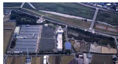
園田配水場 供用開始：昭和 42 年
