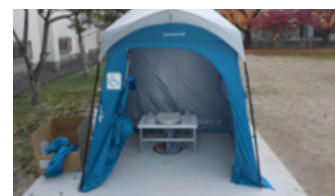
マンホールトイレの設置例
