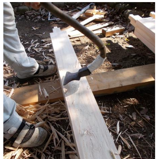
手斧での板材表面の加工
