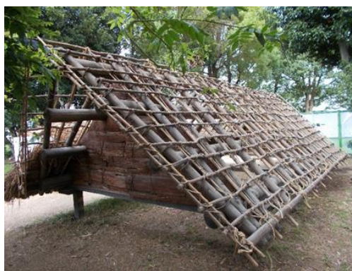
撤去した古い屋根の構造を間近に見学できます。
