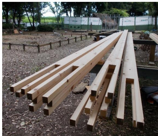
ノミで加工された板材の仕口
