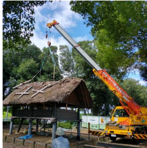
7月から工事が始まりました。
