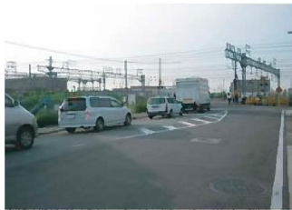
長洲久々知線の整備 (H28年)
