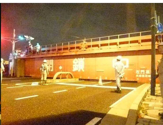
鉄扉閉鎖完了
