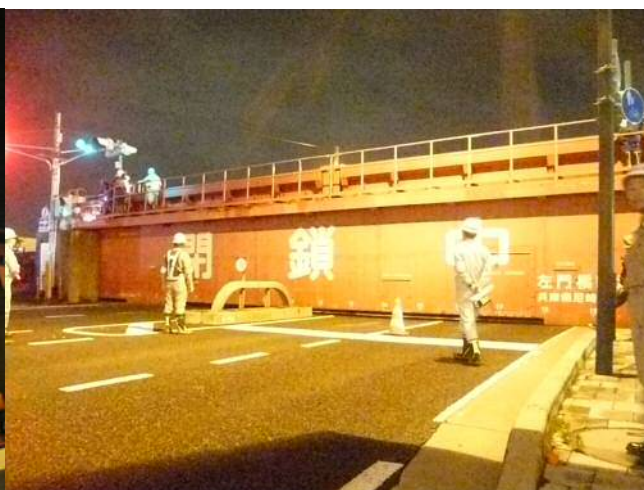
鉄扉閉鎖完了
