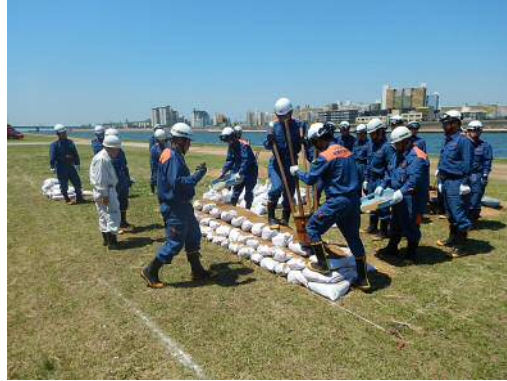
土のう積み工法
