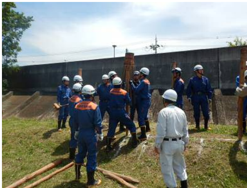
杭打積土俵工法
