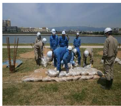
土のう積み工法
