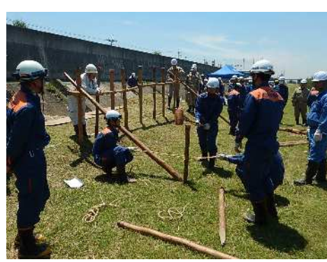
杭打積土俵工法
