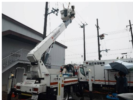
送電線復旧訓練の様子
