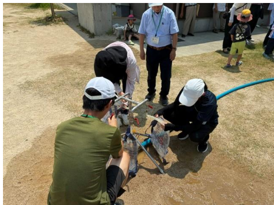
応急給水栓の設置
