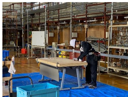
電気工事競技①
