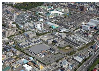
阪神水道企業団尼崎浄水場
