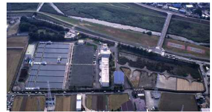
園田配水場 供用開始：昭和 42 年
