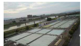
北部浄化センター
