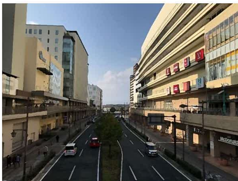
あまがさき緑遊新都心土地区画整理事業により商業・業務地に転換された JR 尼崎駅周辺
