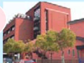
新 身体障害者福祉会館 (教育・障害福祉センター(2階))
