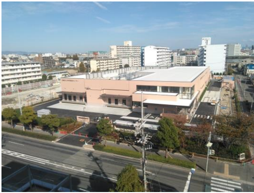
学校給食センター外観
