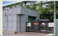
■東難波雨水ポンプ場運転開始
