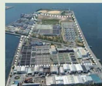
■武庫川下流処理場運転開始 大庄中継ポンプ場より汚水圧送開始
