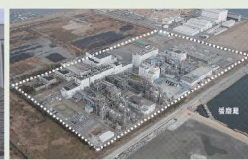
■兵庫東下水汚泥広域処理場運転開始
