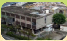
し尿処理施設 昭和 47 年度から令和 8 年度まで稼働
