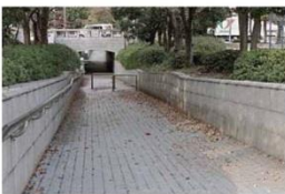
国道2号線地下通路
