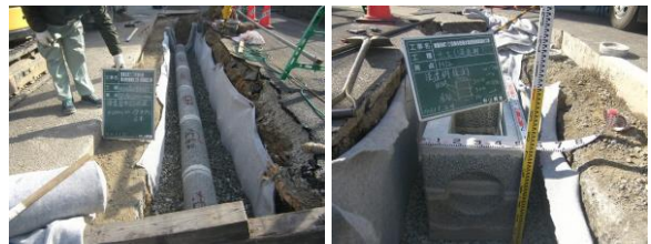
雨水浸透管・雨水浸透ますの設置
