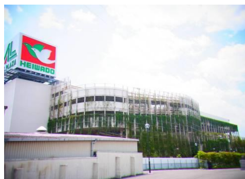
商業施設における建築物緑化
