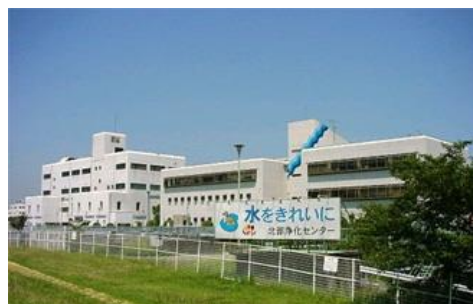
北部浄化センター
