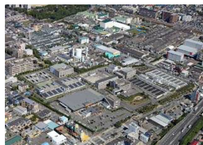
阪神水道企業団尼崎浄水場
