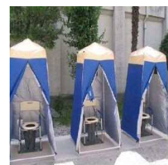
マンホールトイレ
