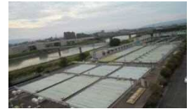
北部浄化センター
