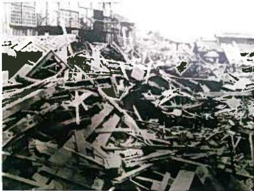
1934(昭和9)年の室戸台風により、尼崎では木造校舎に大きな被害が出ました。写真は尼崎尋常高等小学校の被災状況
