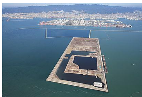
▲神戸沖埋立処分場
