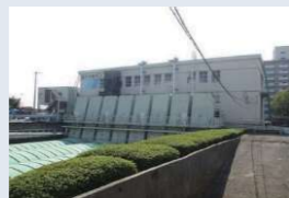
西川中継ポンプ場運転開始
