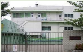
尾浜中継ポンプ場運転開始
