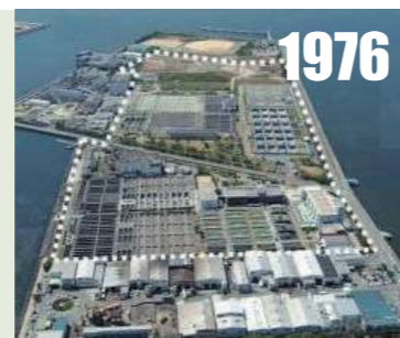
武庫川下流処理場運転開始 大庄中継ポンプ場より汚水圧送開始
