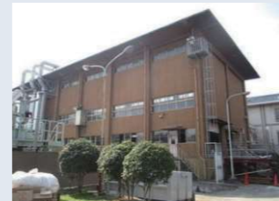
中在家中継ポンプ場運転開始
