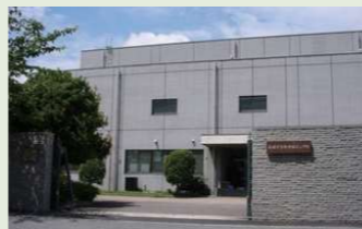
富松中継ポンプ場運転開始
