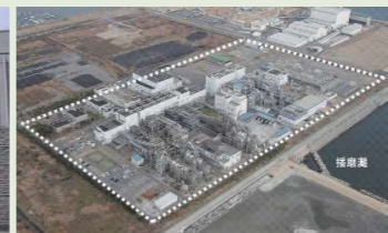
兵庫東下水汚泥広域処理場運転開始
