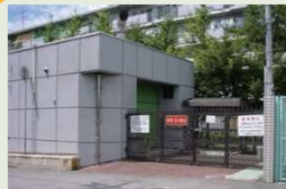
東難波雨水ポンプ場運転開始
