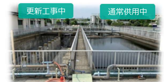
北部浄化センター最終沈殿池 更新、耐震化写真
