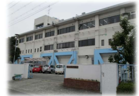
栗山中継ポンプ場 耐震化後写真
