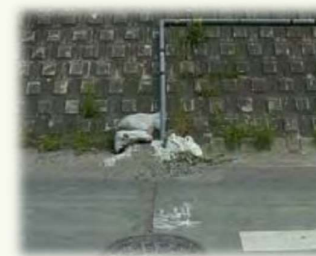
マンホールポンプによる仮配管
