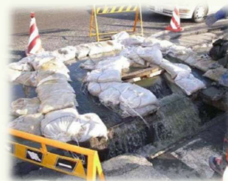
土のうを利用した仮排水路
