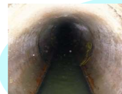
管きよ工事前
