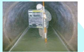
管きよ調査状況
