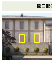
開口部を塞ぐことで、施設内に水が流入しないようにし、設備の機能を確保します。
