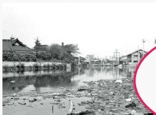
昭和40年頃の汚れた大物川
