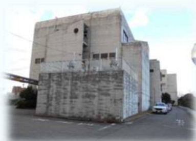
【外壁塗装の施工前】
