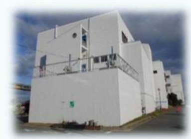
【外壁塗装の施工後】
