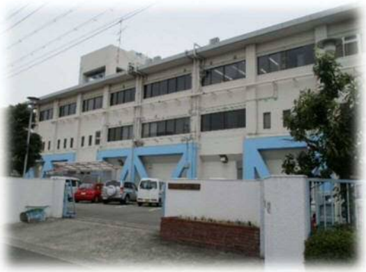
栗山中継ポンプ場 耐震化後写真
