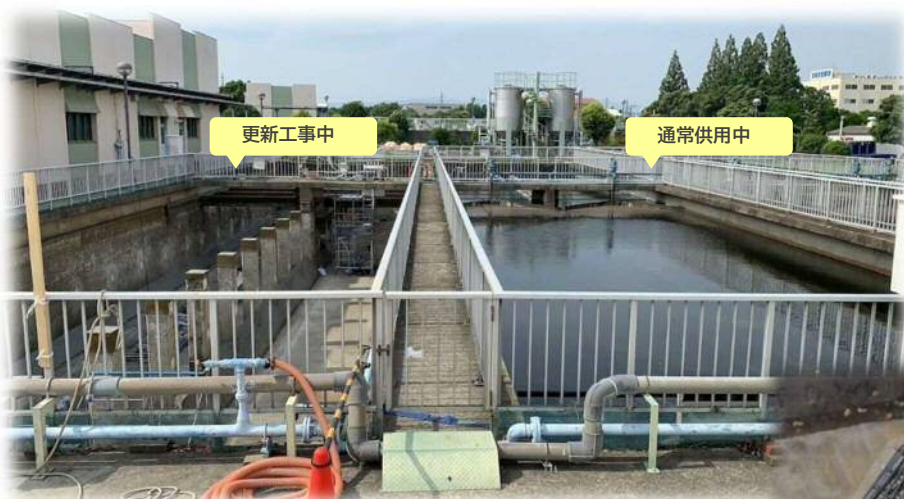
北部浄化センター最終沈殿池 更新、耐震化および高度処理化状況
