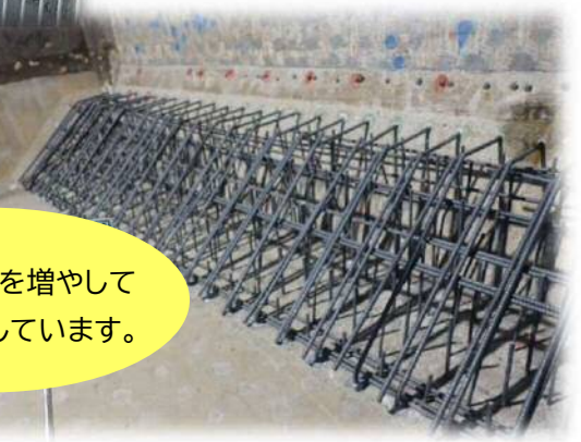
北部浄化センターエアレーションタンク 更新、耐震化および高度処理化状況
