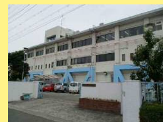
施設の耐震化(栗山中継ポンプ場)
