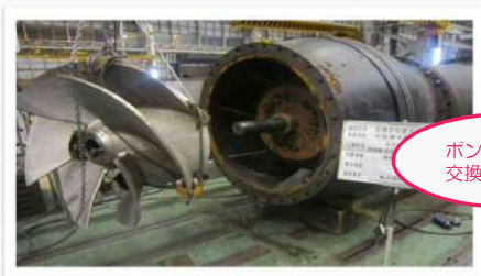
【雨水ポンプ設備の整備前】
