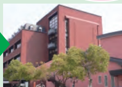
新身体障害者福祉会館 (教育・障害福祉センター2階)
