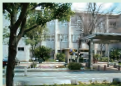
立花庁舎 (立花支所)
