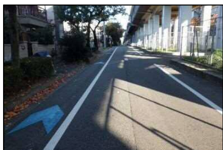
写真10 (再掲) 新幹線側道 (矢羽根)
